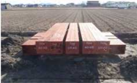
写真-1 住宅実荷重による沈下計測状況(岡山市浦安)
